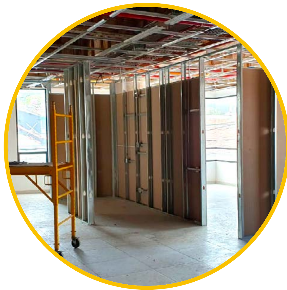
Centro de Atención en Salud Chía - Remodelación sede actual
