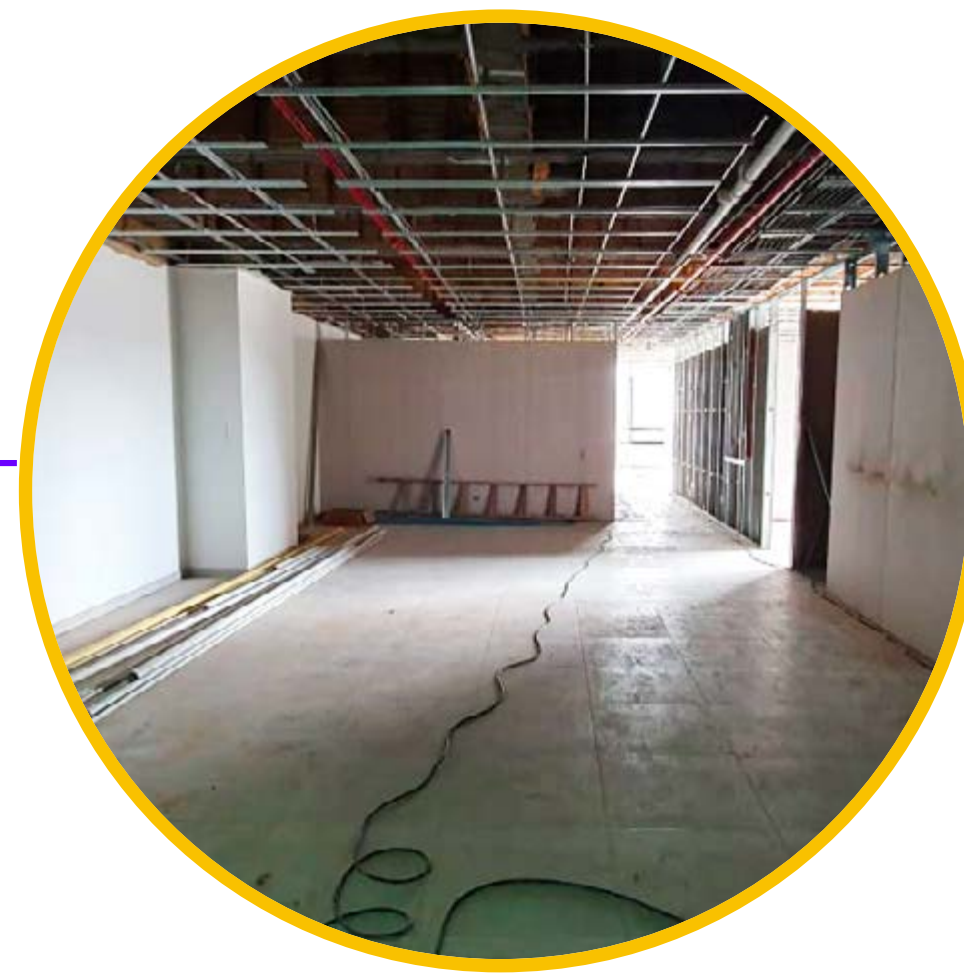
Centro de Atención en Salud Soacha - Remodelación sede actual
